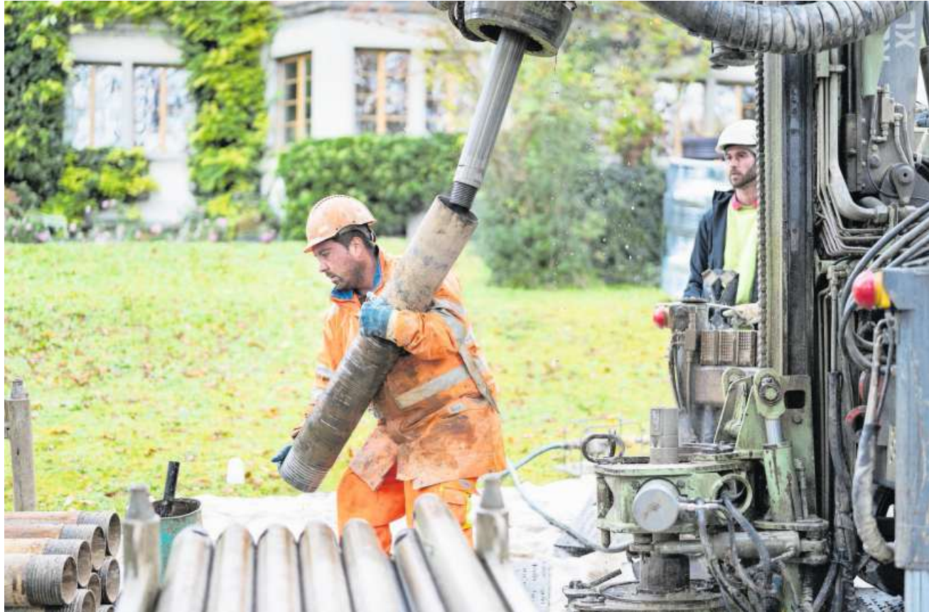
Der Bau von Wärmepumpen nimmt Fahrt auf, wie hier im Garten eines Hauses in Zürich.
